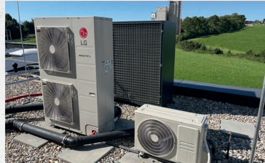
↑ Die kältetechnischen Anlagen für den Direktverdampfer und die Raumkühlung auf dem Flachdach.
