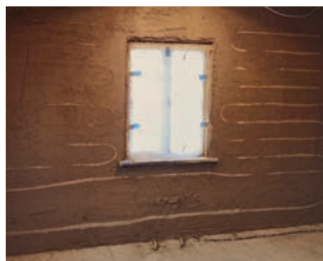
↑ Wasserführende Wandheizung unter Lehmputz
