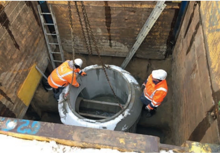
↑ Für die Anbindung ließen die Ingenieure die obere Hälfte der Schmutzwasserleitung öffnen, setzten einen Stülp schacht auf und dichteten ihn ab.
