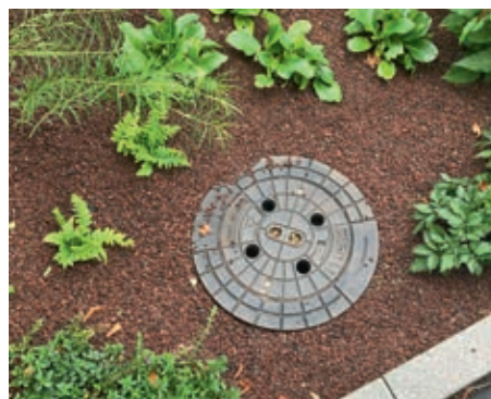
↑ Schacht der Solebohrung für die Wärmepumpe
