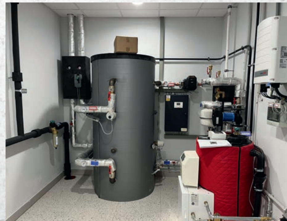
← Im Technikraum stehen Pufferspeicher für die Luft-Wasser-Wärmepumpen sowie Expansionsgefäße und Hydraulikmodule.
