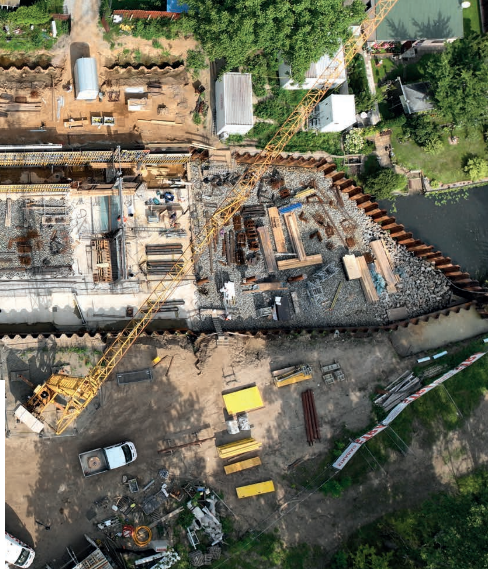
↑ Die Luftaufnahme gibt einen guten Überblick über die Arbeiten im allseits geschlossenen Spundkasten
