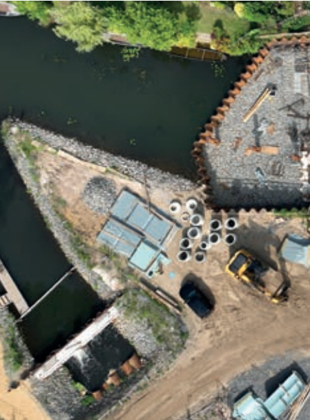
↑ Während der Bauzeit wurde die Berste durch ein Umgehungsgerinne mit Staukopf am rechten Ufer geleitet (links unten)
