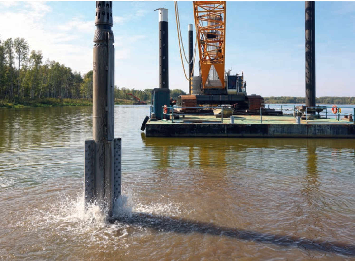
↓ Die vibrierende Rüttellanze wird in den Boden eingefahren. Das schrittweise Anheben und erneute Absenken sorgt für eine gleichmäßige Verdichtung
