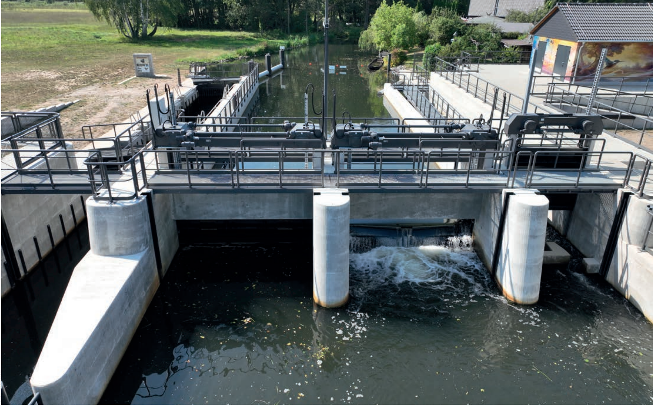
↑ Links die Schleuse, in der Mitte das Wehr, rechts die Fischaufstiegsanlage in Form eines Vertikal-Slot-Fischpasses
