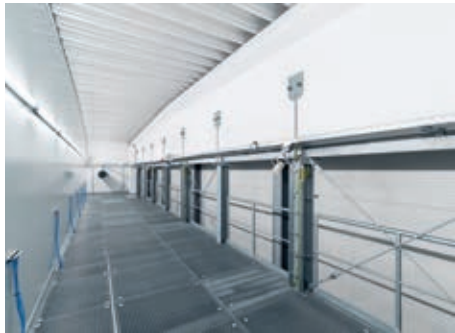
↑ Das Plenum über dem Reinraum im 2. Obergeschoss
