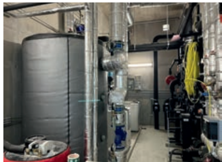
↑ Pufferspeicher der Wärmepumpe
