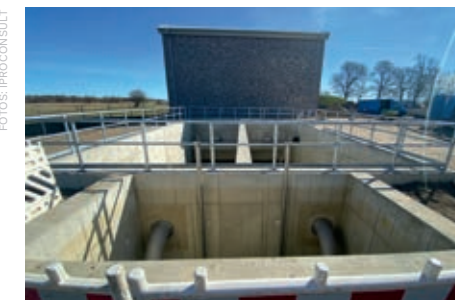
Die zweistraßige Aufbereitungsanlage mit je drei Filterkesseln und die Außenanlagen des Wasserwerks
