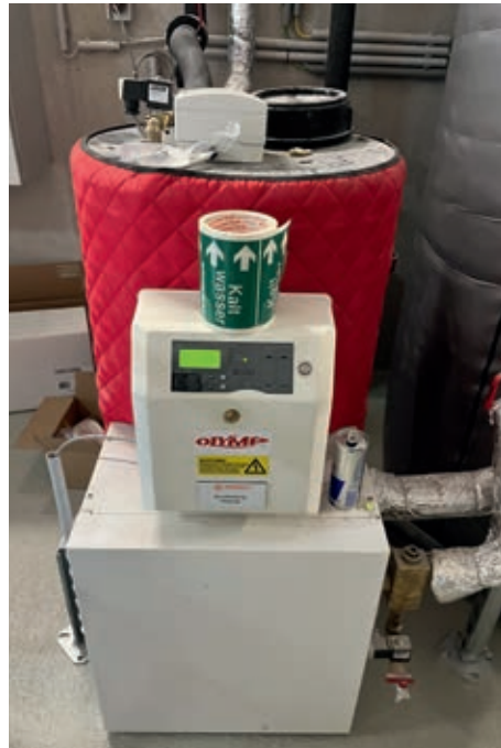
↑ Heizwassercontroller und Expansionsgefäß
