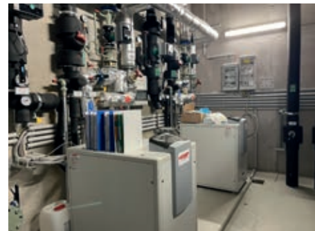
↑ Wärmepumpe mit hydraulischer Schaltung
