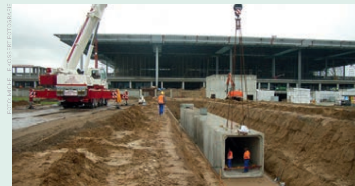
↑ Montage des Regenwassersammlers am Flughafen BER
