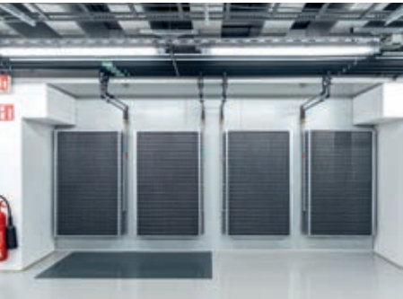
↑ Kühlregister zur Kühlung der Umluft
