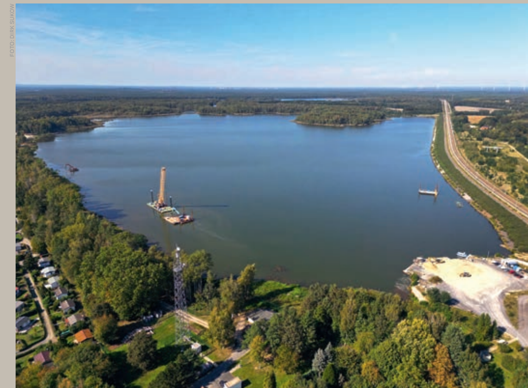
↑ Seeseitige Rütteldruckverdichtung am Silbersee in der Lausitz
