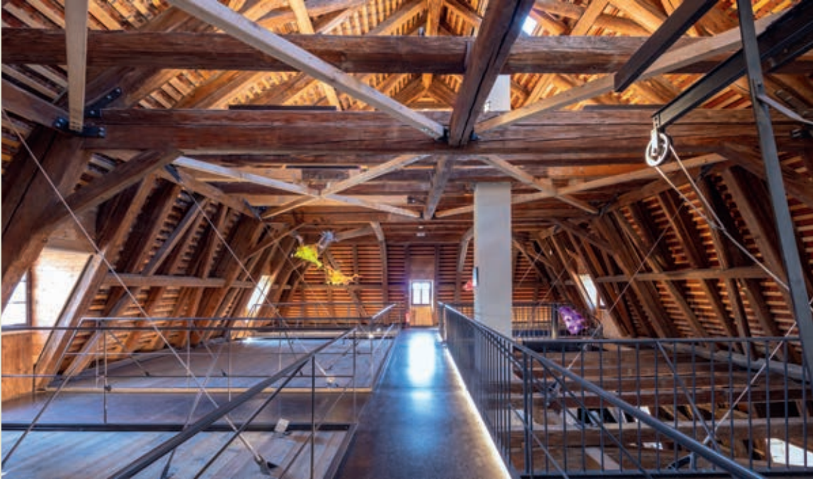
↓ Der Dachstuhl wurde vom Schweizer Baumeister Jacob Grubenmann stützenfrei errichtet.
