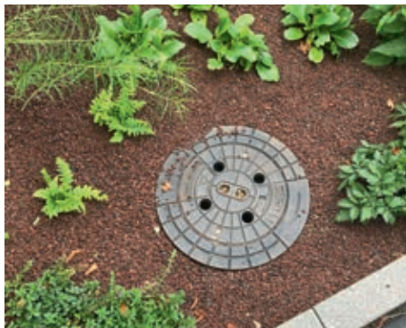
↑ Schacht der Solebohrung für die Wärmepumpe
