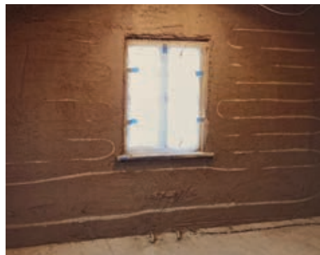
↑ Wasserführende Wandheizung unter Lehmputz
