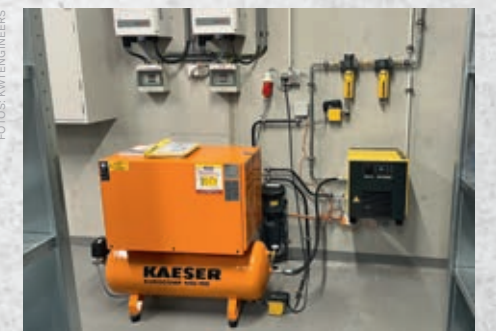
↑ Die Druckluftanlage im Werksgebäude versorgt die Laborbereiche und die Waschstraße.
